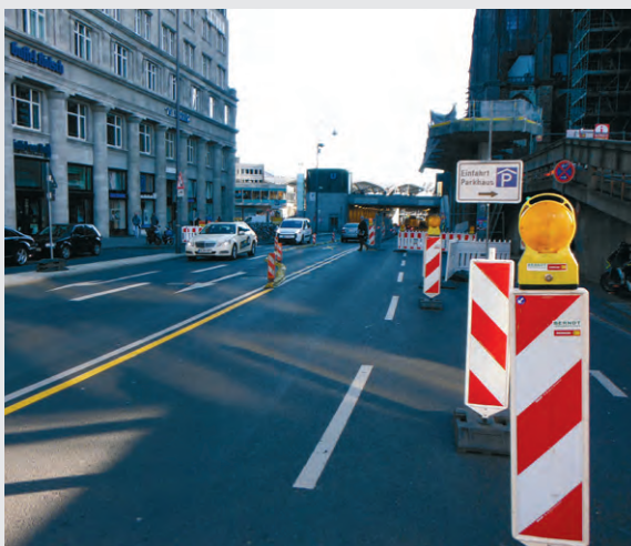
Bild 8 | Führung des Radverkehrs entlang Arbeitsstelle im Mischverkehr bei hoher Kfz-Belastung (die Schraffen der Bake zeigen stets auf der Verkehrsseite nach unten)
