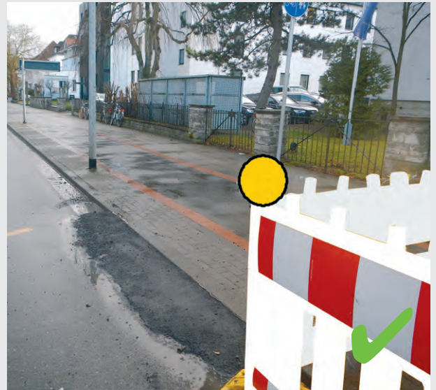
Bild 7 | Anrampung in Form von Asphaltkeil hergestellt
