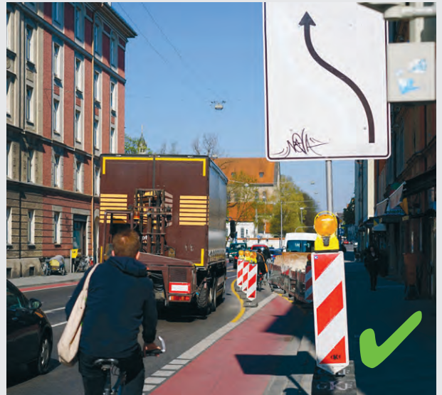
Bild 15 | Arbeitsstelle auf Radfahrstreifen durch Abspernung gesichert
