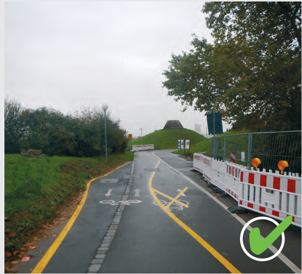
Bild 4 | Gut sichtbare Absperrung und Gelb-Markierung
