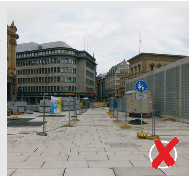
Bild 3 | Schlecht sichtbare Absperrung (z.B. ist im Dunkeln der Zaun nicht sichtbar und die Wegführung schlecht erkennbar).
