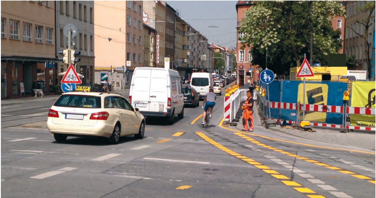
Bild 11 a | Deutlich erkennbare Einleitung Radverkehr vom Radweg zur Fahrbahn an einem Knotenpunkt
